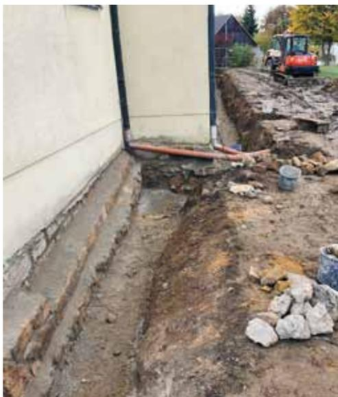
Die freigelegten und sanierten Fundamente auf der Rückseite der Kirche
